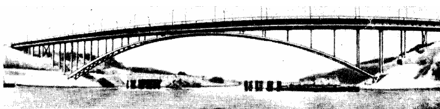
Рис. 90. Рамный мост ("бегущая лань")
